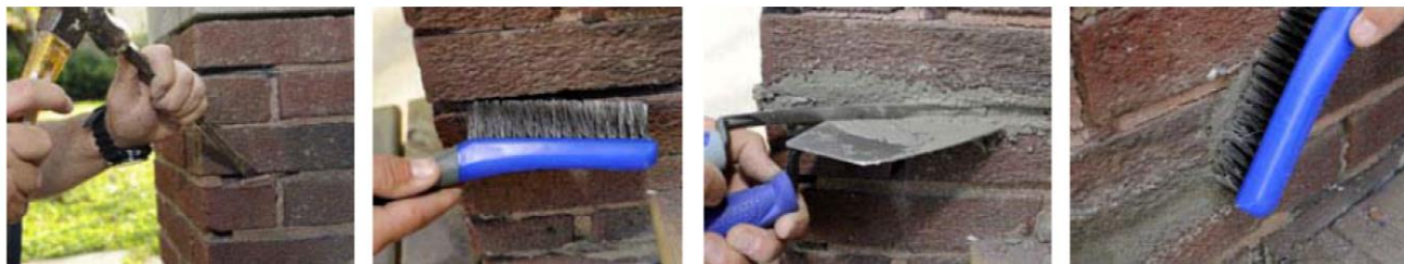
Slika 9. Djelomična zamjena morta u sljubnicama
